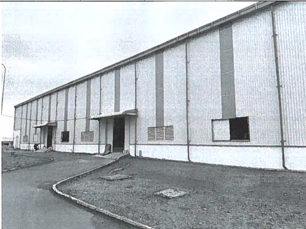
Khu vực xử lý vỏ sầu riêng thay đổi công năng thành kho chứa cách ly nguyên liệu đầu vào không đạt chuẩn
