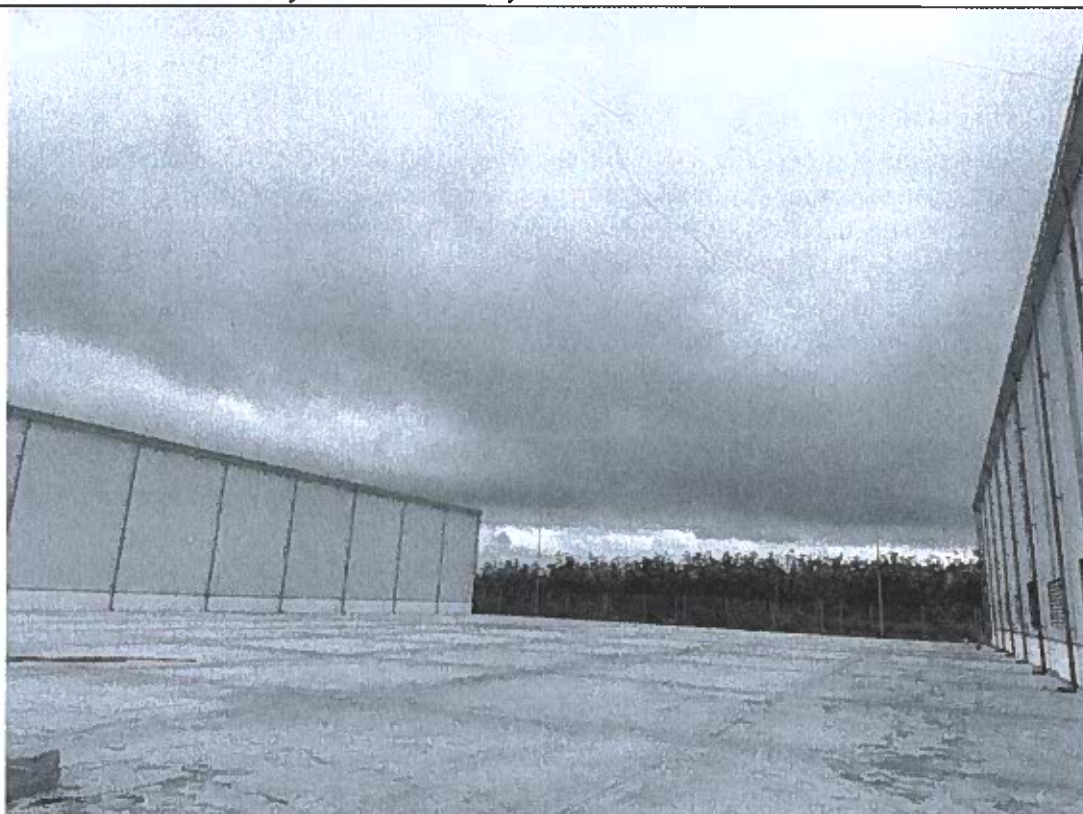
Khu vực ủ/ xử lý vỏ sấu riêng thay đổi công năng thành sân hoạt động chung
